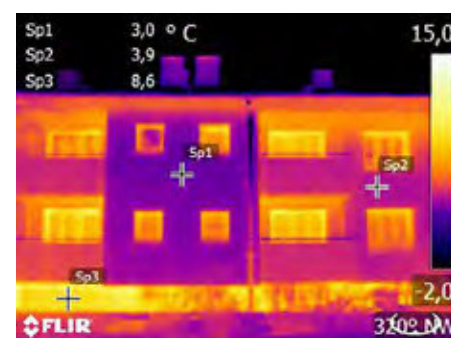
Abbildung 4: Thermografiebild einer Hausfassade, welche gerade thermisch saniert wird. Der bodennahe Mauerstreifen (Kellergeschoss) ist noch nicht saniert und daher deutlich wärmer (um ca. 5° C) als die oberen bereits sanierten Mauerbereiche
